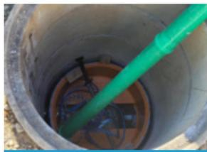
Verfüllung zwischen altem und neuem Schacht
