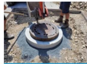
Schachtabdeckung montiert, Straßenbelag geschlossen
